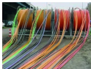
Déroutage des tuyaux ege=com® Macroduct Mono sur chantier
