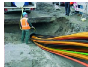
Introduction de plusieurs tuyaux ege=com® Macroduct Mono dans une gaine existante
