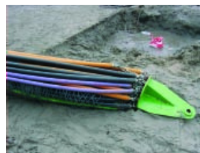
Tuyaux ege=com® Macroduct Mono avant introduction dans une gaine existante
